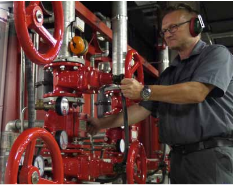
Rechts steht Raimund Brütting an der Steuerung der Sprinklerzentrale.
