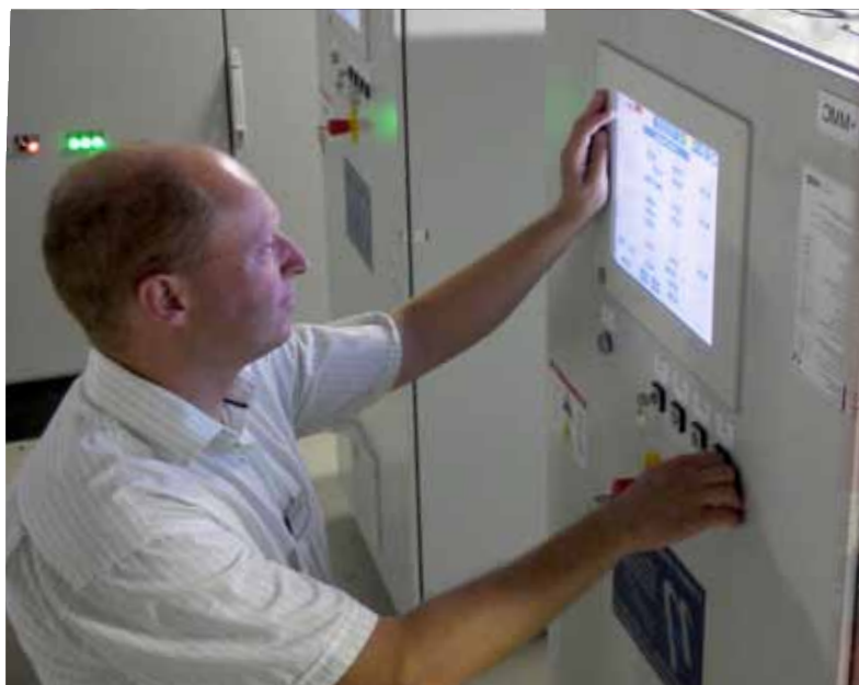
Links bedient der Technische Leiter, Dipl.-Ing. Thomas Müller, das 2014 installierte Blockheizkraftwerk
