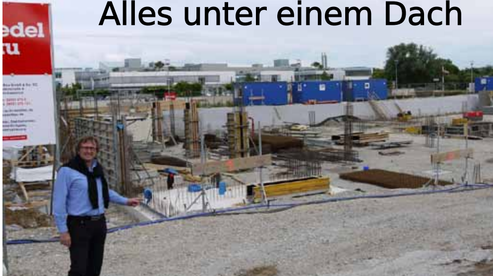
Architekt Herbert Amtmann vor der Baustelle des Gesundheitszentrums Foto: miwu
