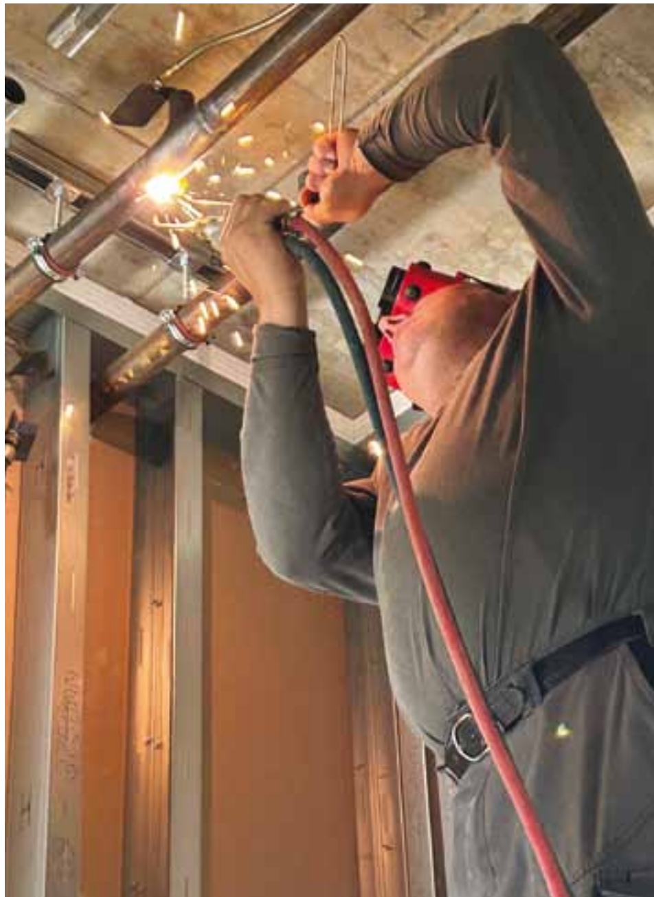
Es wird geschweißt, dass die Funken fliegen.
